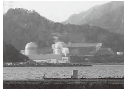
稼働停止の仮処分命令が出された高浜原発4号機 (撮影者 入江 昶史さん)
